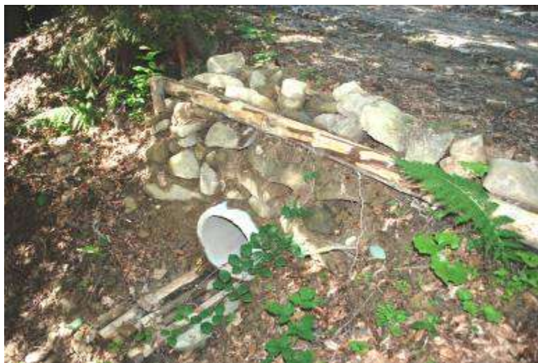
Przykłady studzienek i ścianek wylotowych na przepustach betonowych
