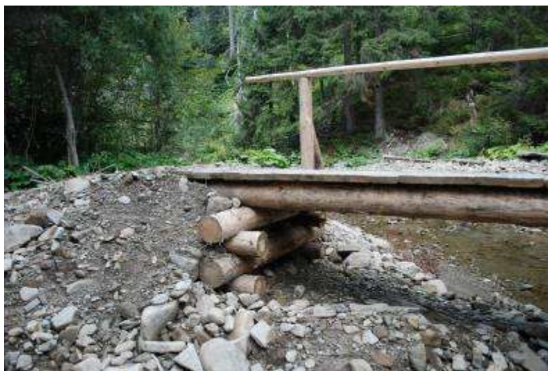
Przykład kładki na większym cieku wodnym
