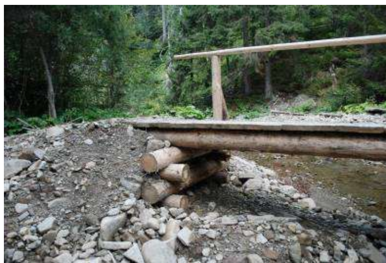
Przykład kładki na większym cieku wodnym
